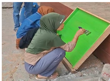
Gambar 4. Proses Pengecatan Plang warna Hijau
